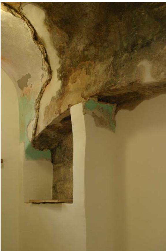
Zeitfenster Küche Erdgeschoss
